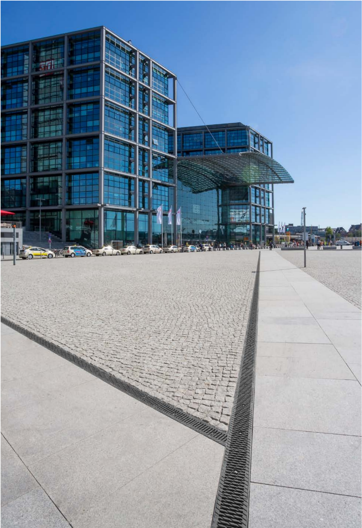
BIRCOLight® mit Stahlzarge am Hauptbahnhof Berlin
