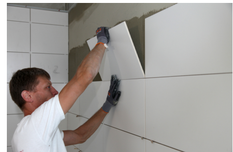
Funktionssichere Fliesenverlegung im Dünnbettverfahren mit PCI FT Klebemörtel
