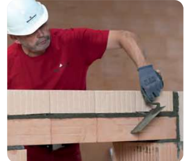
Höhenausgleichsziegel im Sturzbereich.
