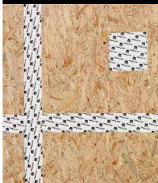
OSB-Platten luftdicht abkleben
