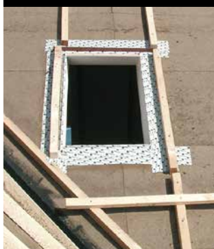
Dachfenster anschliessen
