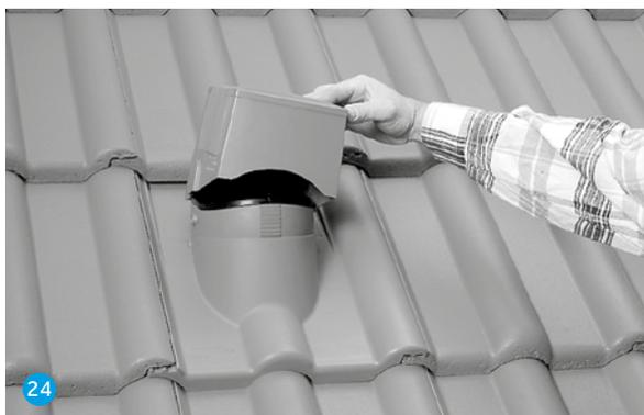
Das System besteht aus der Durchgangspfanne mit Anschlussrohr. Das Anschlussrohr steht wahlweise in DN 125 oder DN 110 zur Verfügung. Auf die Durchgangspfanne wird das Oberrohr oder der Sanilüfter (Foto) aufgesetzt. Der Sanilüfter ist dachneigungsunabhängig, das Oberrohr lässt sich bei Dachneigungen von 15° bis 55° senkrecht ausrichten. Beide Systeme sind mit Öffnungen für Kondensatablauf ausgerüstet.
