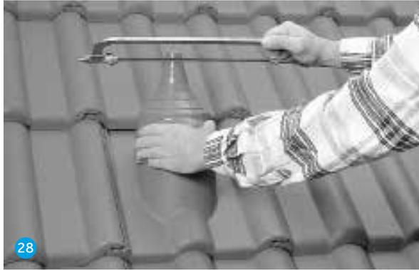
Der DuroVent Antennenaufsatz ist geeignet für die Dachdurchführung von Antennenmasten.
