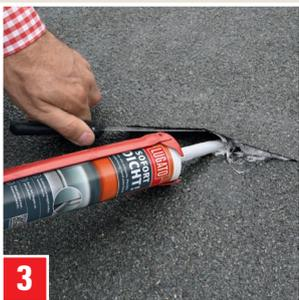
**Rissverschluss in einer Bitumendachbahn: Riss mit einem Spachtel offen halten und SOFORT DICH! in den Spalt füllen.**
