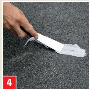
Bitumendachbahn wieder andrücken und herausquellendes Material mit einem Spachtel glatt streichen. Nahtstelle deckend überspachteln. Bei Verarbeitung auf feuchten Untergründen empfiehlt es sich, zur Haftungsverbesserung SOFORT DICH! mit einem Pinsel einzumassieren.
