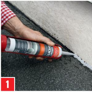
**Abdichten einer Anschlussfuge auf dem Dach mit SOFORT DICH! aus der Kartusche: SOFORT DICH! mit Auspresspistole in die Fuge ausspritzen.**
