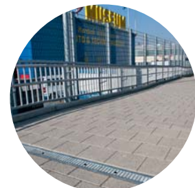
Rampe Haltestelle Sinsheim
