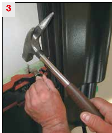
... und von oben in die Traglattung einschlagen.
