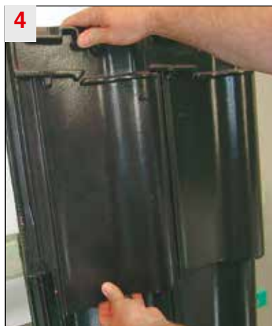
Dachziegel eindecken und andrücken. Fertig!
