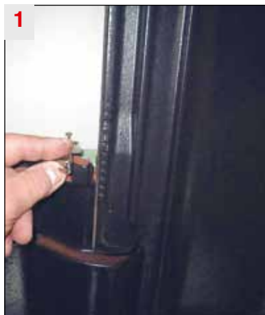
Multi-Sturmkralle über den Kopffalz...
