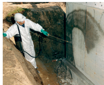
Blasenfreie Abdichtung mit Bitumen-Dickbeschichtungen auf Betonaußenwänden nach der Grundierung mit PCI Pecimor-Betongrund.
