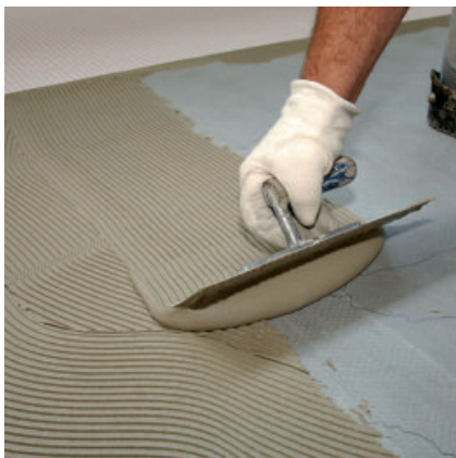
In das frisch aufgekämmte Kleberbett...
