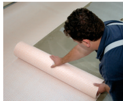
Mit PCI Pecilastic können Keramik- und Naturwerksteinbeläge funktionssicher entkoppelt werden.
