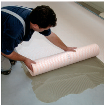
werden die PCI Pecilastic-Bahnen eingelegt...
