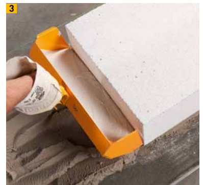
Stoßfuge vermörteln
