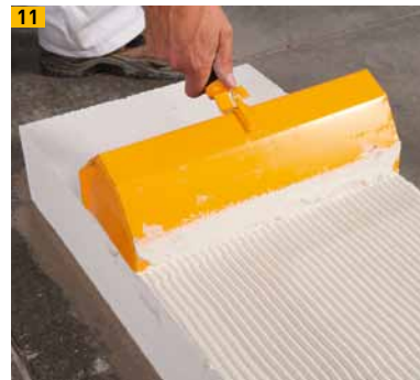
11 Auftragen Dünnbettmörtel mit Plankelle
