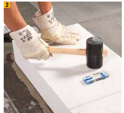
Ausrichten der Ausgleichschicht
