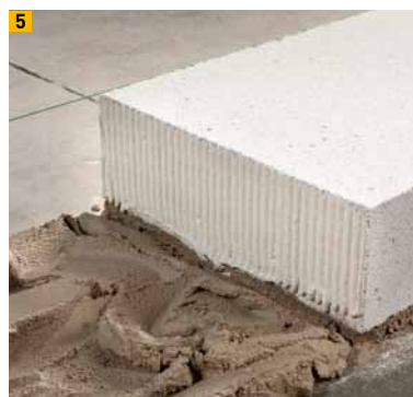
Vollflächig vermörtelte Stoßfuge
