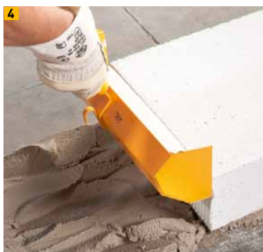
Stoßfuge vermörteln
