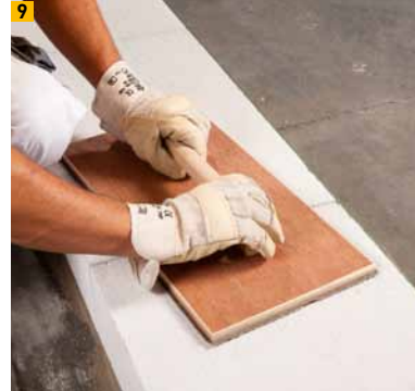
9 Schleifen mit Schleifbrett
