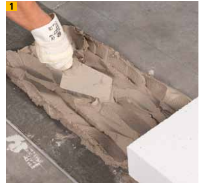
Auftragen der Normalmörtelschicht
