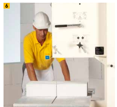
Sägen mit Bandsäge
